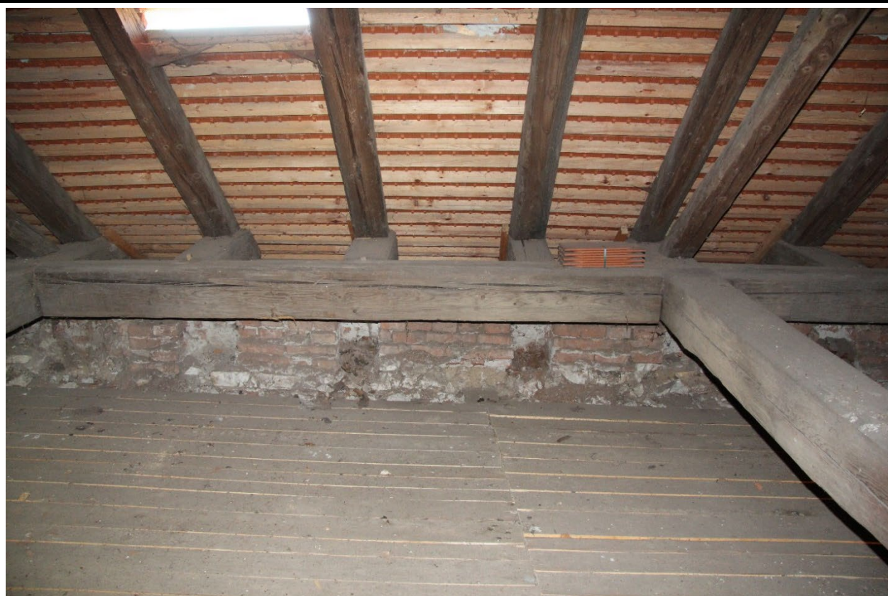
Detail jižní koruny zdi lodi v pohledu od severu s patrnými kapsami po vazných trámech staršího krovu z roku 1689. Foto: Jaroslav Skopec 2019.
