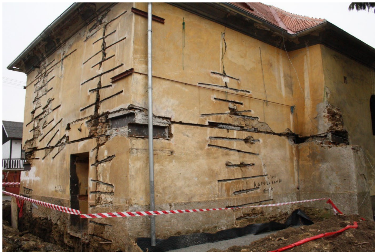
Presbytář v době statického zabezpečování v pohledu od východu. Foto: Jaroslav Skopec 2013.
