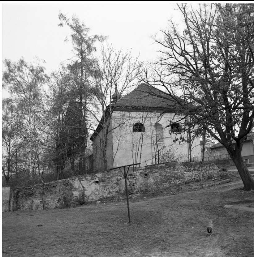
Celkový pohled od západu. Foto: 1988, sbírka negativů NPÚ ÚOP v Ústí n. L., sign. 94618.
