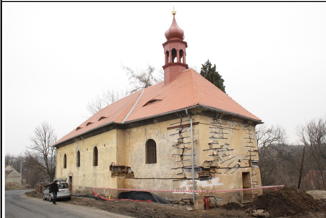
Celkový pohled od jihu v době statického zabezpečování kostela. Foto: Jaroslav Skopec 2013.
